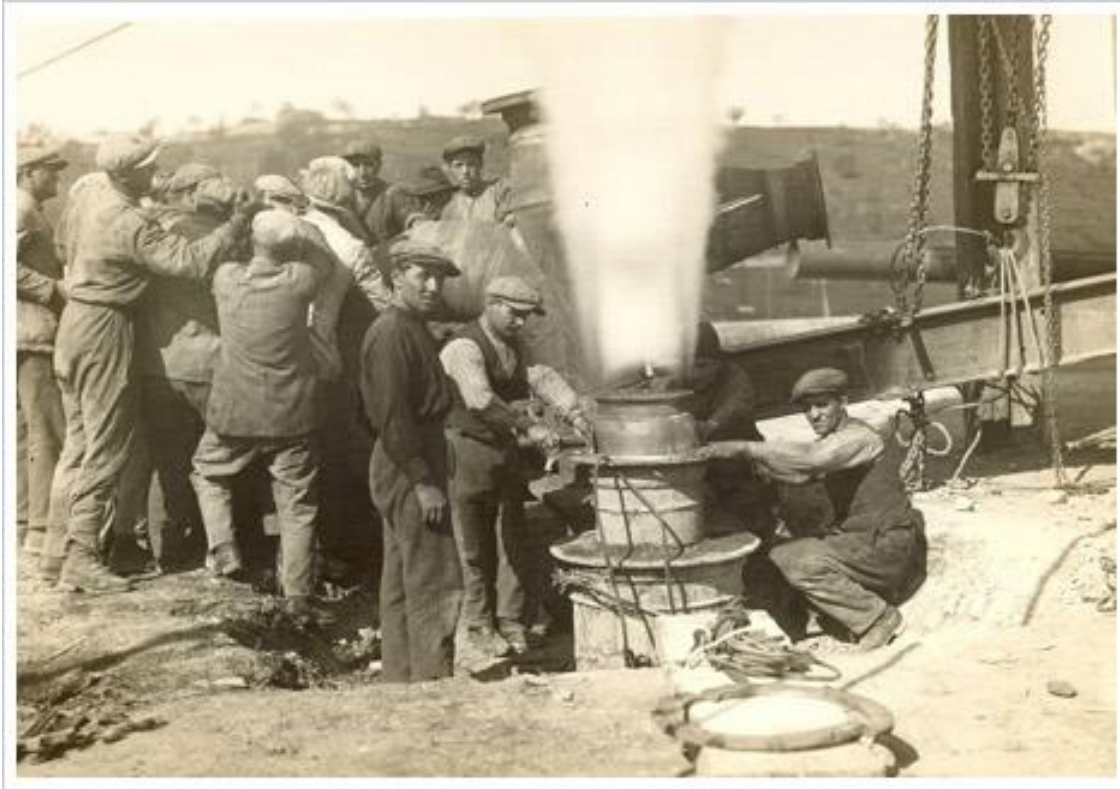
Larderello. Manovre per l'imbrigliamento del soffionissimo n.2 nel piano dei vasconi. 14/05/1932
